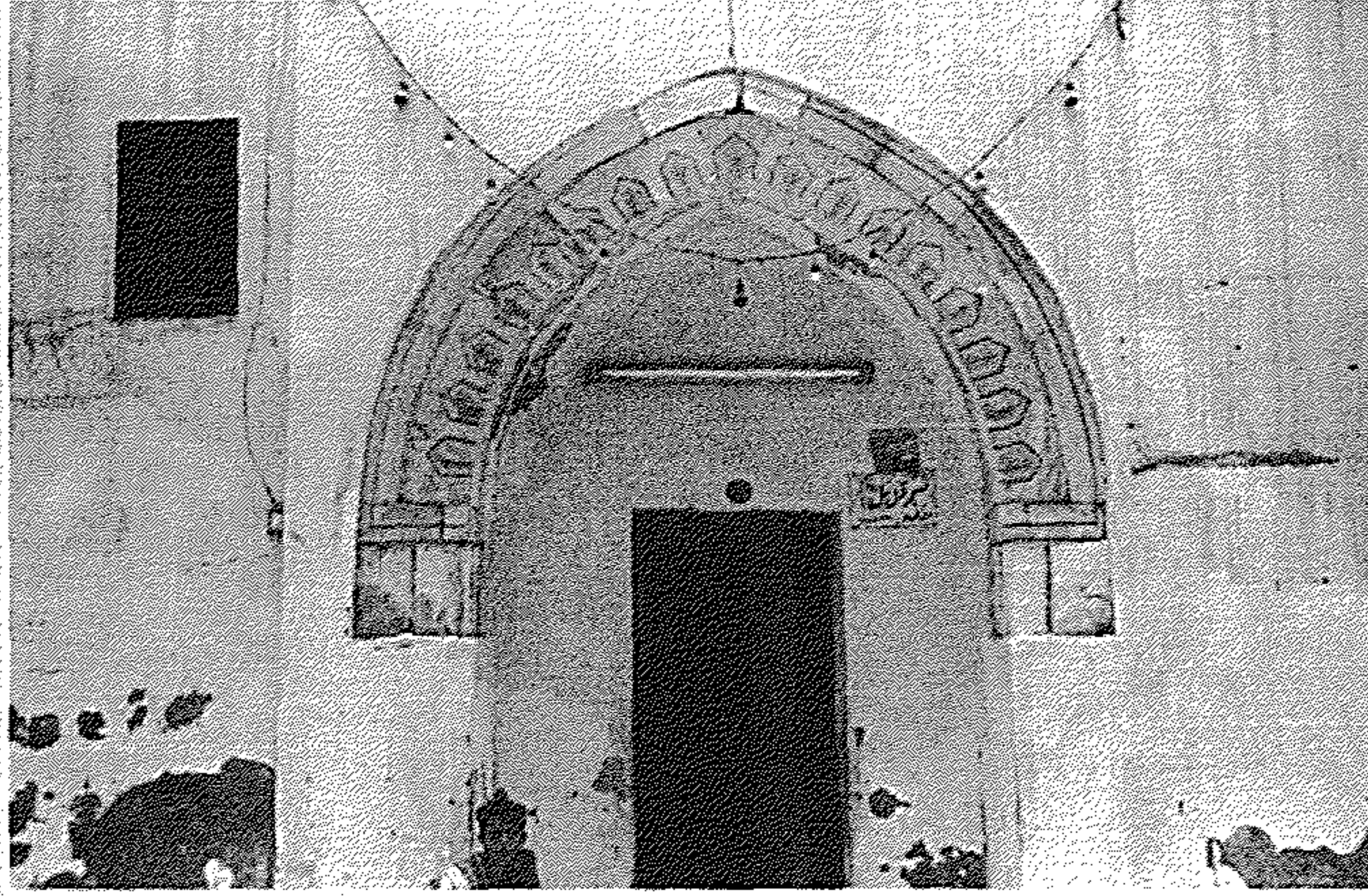
لوحة رقم ( ٦٢ ) : المدخل الرئيسي بالواجهة الجنوبية الغربية لمسجد الشيخ قنديل ويتميز هذا المدخل بعقده الحجري المذيب المنفوخ
